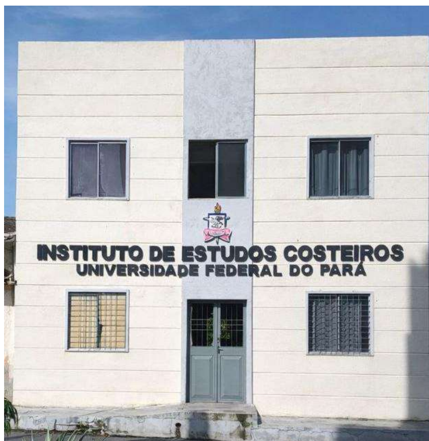
Figura 11 – Fachada do Instituto de Estudos Costeiros
